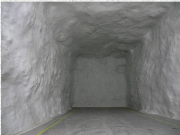
Una delle 34 celle frigorifere scavate nella dolomia
